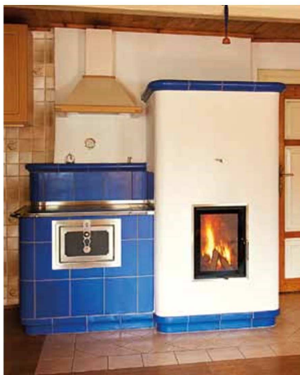
Akumulační sálavá kamna se stavěným topeništěm. Výkon kamen 3,5 kW/h, doba akumulace 12 hodin. Ke kamnům je připojen sporák s pečicí troubou. Později bylo na přání klienta z důvodu úspory dřeva při vaření doplněno samostatné sporákové topeniště
